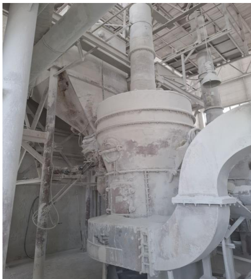
Силос на суров материјал, дозирач, сепаратор
